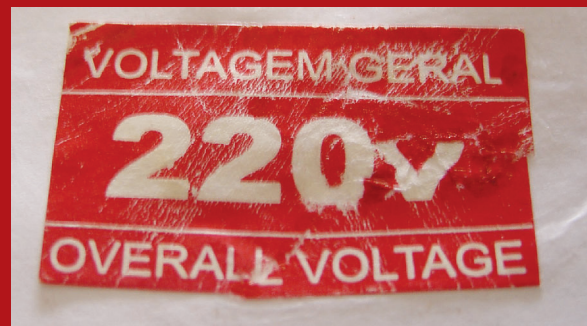
Figura 4 - Etiqueta informando, em português e em inglês, a tensão existente nas tomadas. Informação muito útil, porém, usando um termo "que não existe" na terminologia, e o símbolo da unidade de medida, o volt, deveria ser um "V" maiúsculo, e não minúsculo, como está. Deveria ser "tensão 220 V ou tensão elétrica 220 V". Também não informa se é corrente contínua ou alternada
